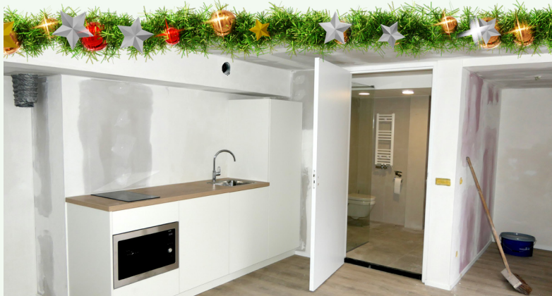
Een deel van het interieur van een nieuw zorgappartement aan de Paterswoldestraat
